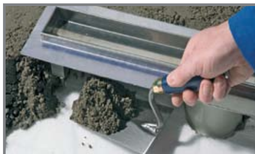
Укладка бетонной стяжки
