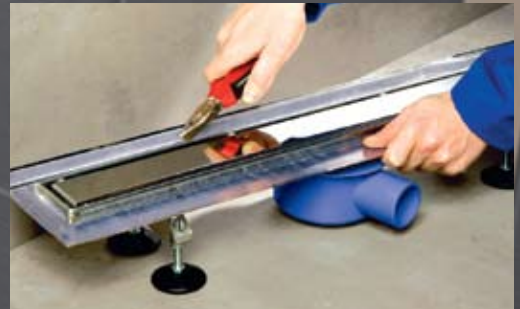
Изгибание фланца перед монтажом
