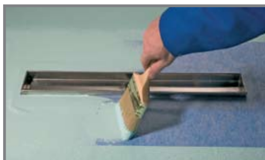
Нанесение гидроизоляционного слоя
