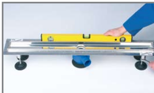
Выравнивание канала по горизонтали с помощью опор
